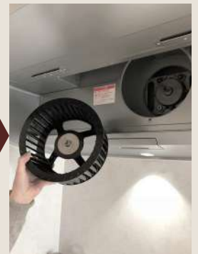
⑤ ファンを取り外す(油汚れで外れにくい事もあります)
