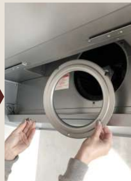
③ 蝶ボルトを外しベ ルマウスリングを外す
