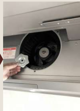
④ ファンの固定ねじを外す(通常のねじと逆の時計回りで緩む)
