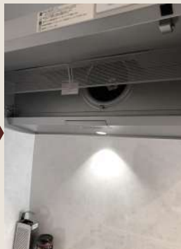
② 整流版を持ち上げ取り外し、ファン手前のフィルターをとる
